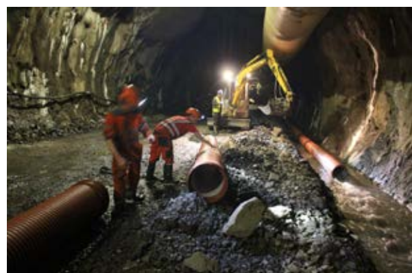
Einbau der 60 cm Wasserleitung.
