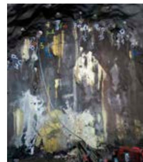
Bild der Ortsbrust nach der Injektion.
