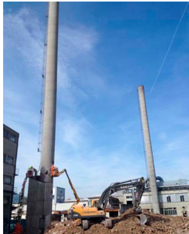
Wahrzeichen von Breitenbach: Sprengobjekt K 15 vorne, hinten K 61
