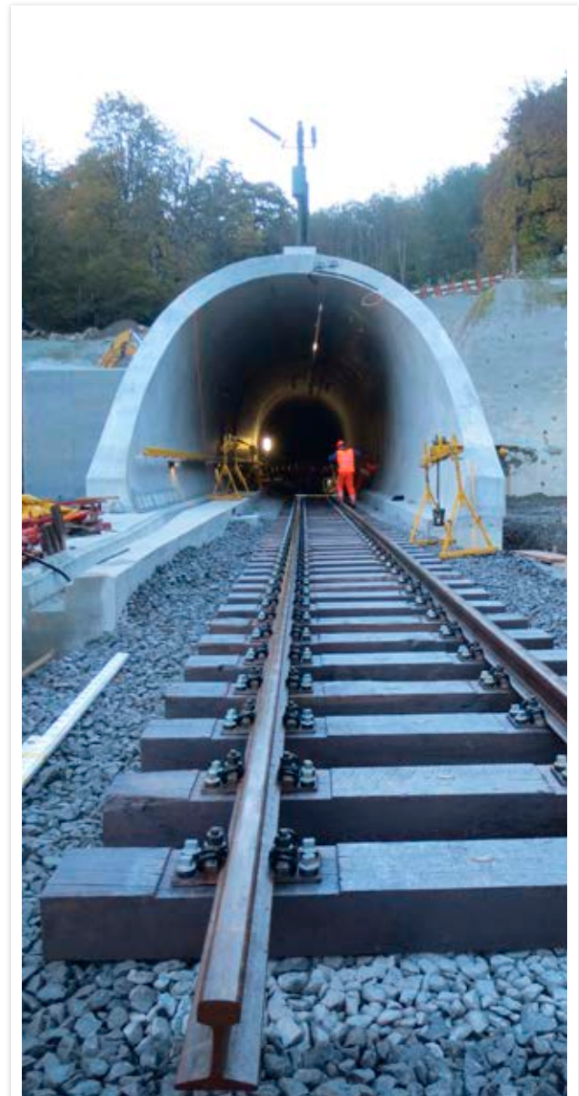
Einbau Schotter, Verlegen der Schienen
