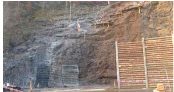
Wand-Lehenkonstruktion
