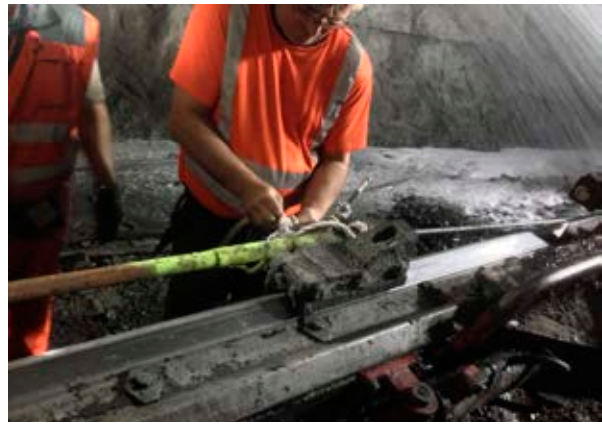
Die Lanzen wurden hinten am Bohrhammer befestigt ...
