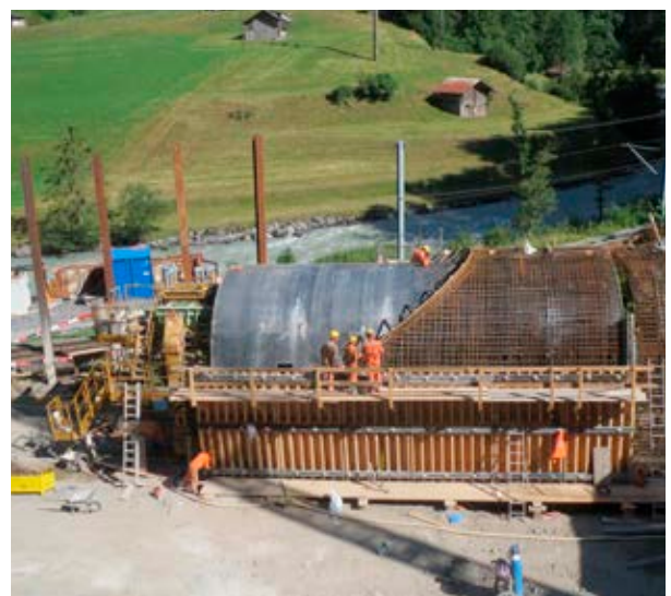
Schalung und Armierung Tagbau West
