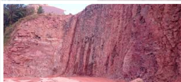
Abb. 7: Vorspaltsprengung mit 26 m Wandhöhe
