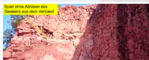
Abb. 8: Vorspaltsprengung mit 26 m Wandhöhe
