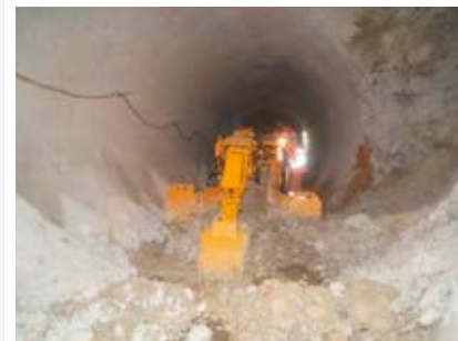
Schutterung mit Häggloader
