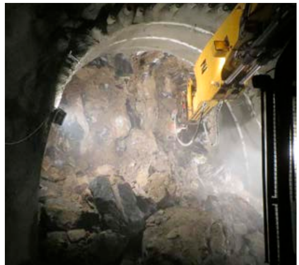
Felsvortrieb mit Tunnelbagger Cat 328D (2)
