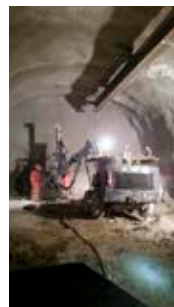
Bohren in den Schacht
