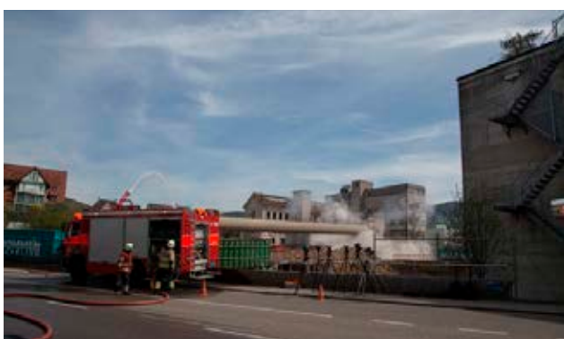
Detonation der 38 Ladungen und Fall des Hochkamins
