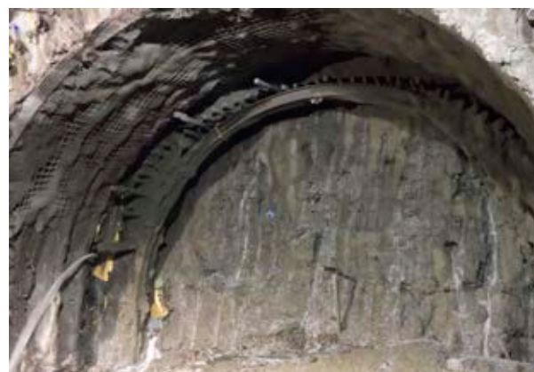
Bild des Tunnels nach den ersten 10 m.
