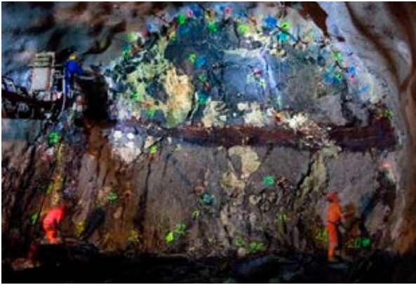
Bild einer Ortsbrust nach der Injektion.
