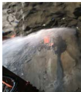
Wenn 30 L/sec Wasser unter einem Druck von 12 Bar aus dem Bohrloch schiessen reicht der Strahl bis zum Bohrwagen.
