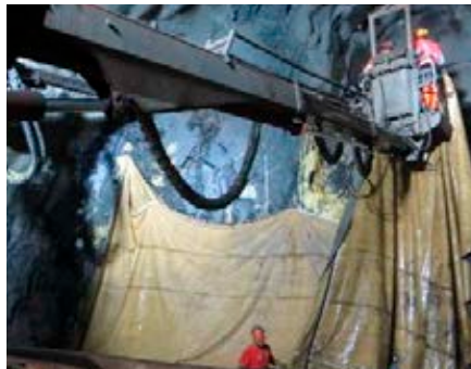
Montage der Plastikfolie auf die Ortsbrust.
