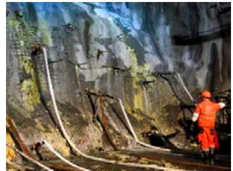
Bild der Staumauer mit den Entlastungsrohren.
