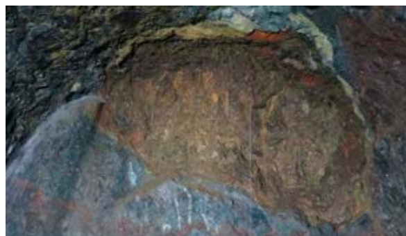
Anfahren der Brekzie bei Station 6460.
