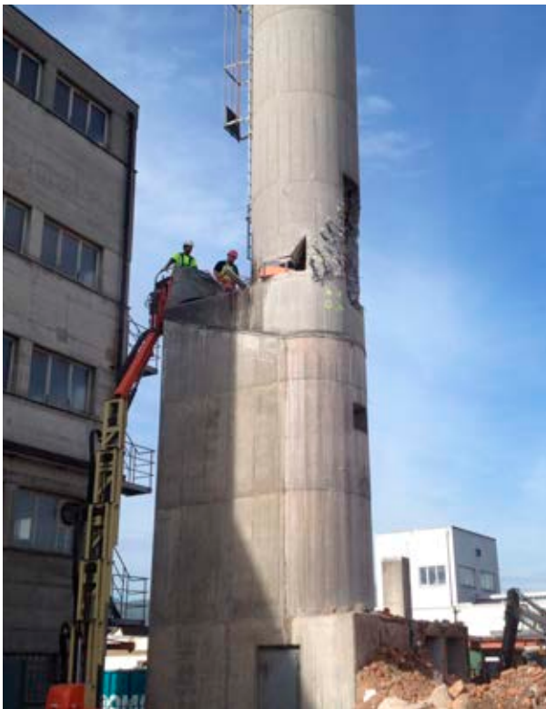
Das Sprengmaul mit Stahlkippgelenken in 9m Höhe
