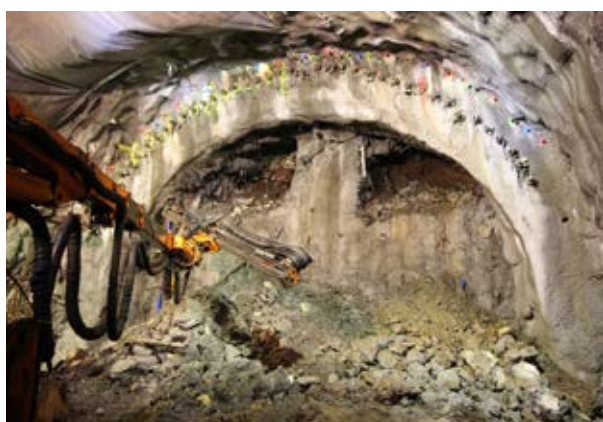
Vorsichtiger mechanisierter Vortrieb mittels Teilausbruch.
