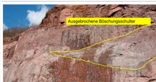
Abb. 6: Ausgebrogene Böschungsschulter nach der Vorspaltsprengung
