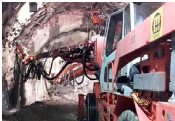
Bohrarbeiten des Rohrschirms.
