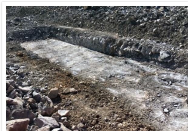
Sohle der gefrästen Fläche
