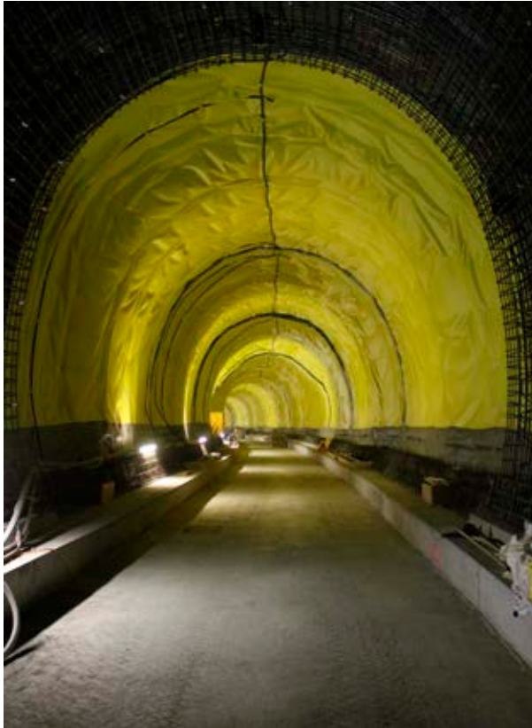
Gewölbeabdichtung und Armierung
