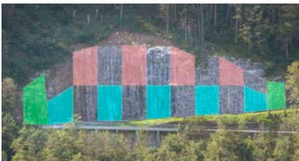
Wand-Lehenkonstruktion
