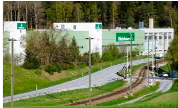
Abfüllanlagen der Rhazünser Mineralquellen in der Undrau, Rhazüns
